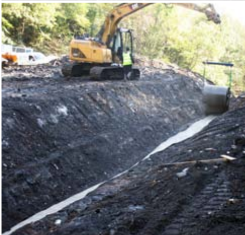
40 linear m continuous longitudinal CC side layer
