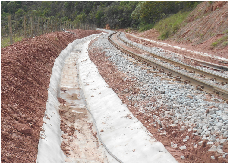
CC laid longitudinally
