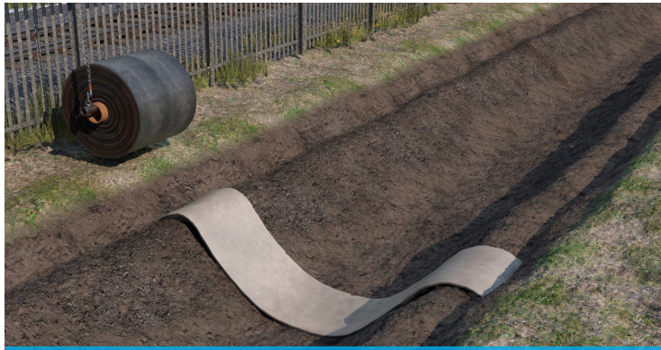
تثبيت الكونكريت كانفاس في خندق التثبيت قبل قص المواد
