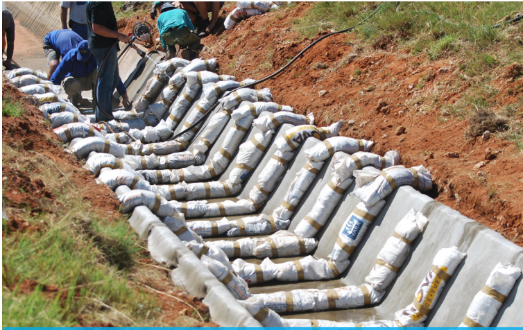
يمكن استخدام أكياس رمل لضغط الوصلات خلال فترة التصلب
