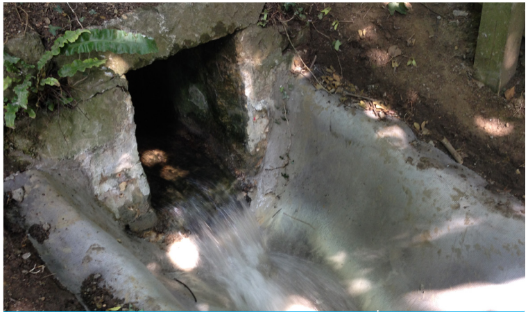
يمكن استعمال مونة أسمنتية مناسبة لوصل وإحكام إغلاق الكونكريت كانفاس البنية التحتية الخرسانية الموجودة
