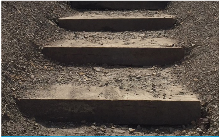
يمكن تشكيل حواجز من خلال وضع الكونكريت كانفاس على هياكل خشبية أو أكياس الرمل
