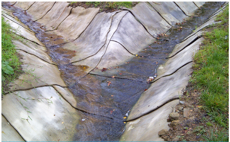
يمكن تشكيل الكونكريت كانفاس بسهولة لعمل تقاطعات ونهايات القنوات
