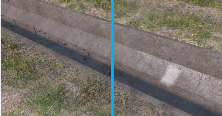
يجب إزالة الخرسانة المتكسرة واستخدام المونة الاسمنتية لملء الشقوق الكبيرة
