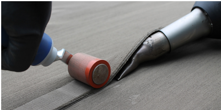
الربط الحراري باستخدام الأدوات اليدوية
