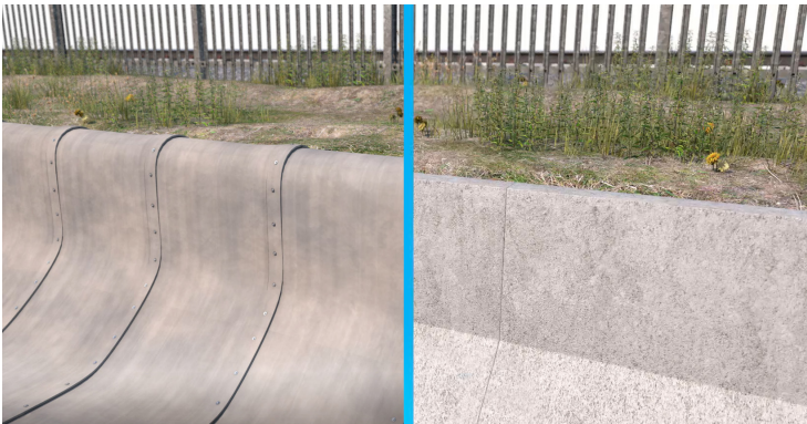
تأكد من وضع الكونكريت كانفاس مع التأكد من عدم وجود فراغات تحته
