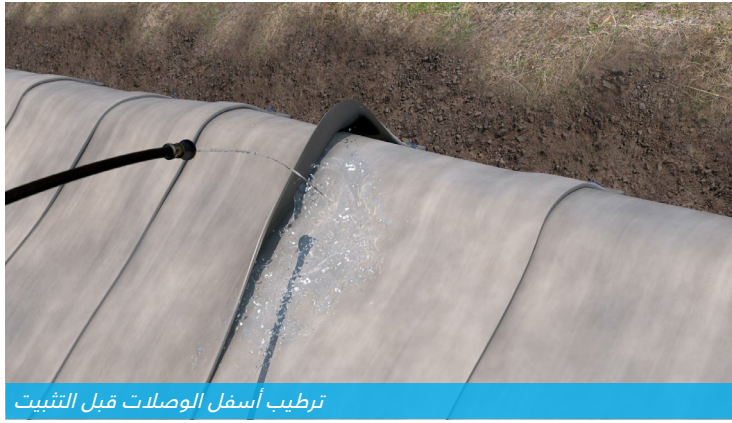
قم بتركيب الكونكريت كانفاس في اتجاه تدفق الماء
