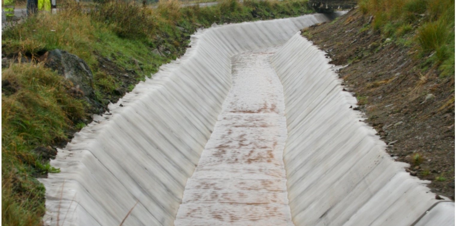
تبطين القنوات بالكونكريت كانفاس - المعالجة العامة للخرسانة، باويرين، اسكتلندا، المملكة المتحدة
