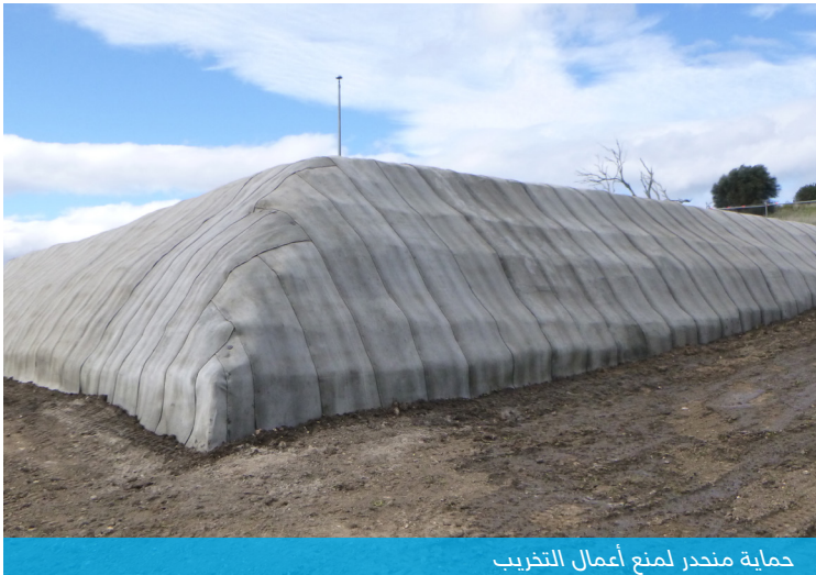
حماية جدران الأرض المثبتة ميكانيكياً لمنع التلف الناتج عن الحيوانات
