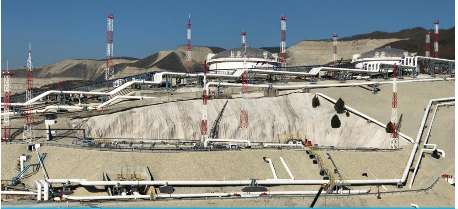
حماية المنحدرات باستخدام الكونكريت كانفاس، مجموعة ضخ النفط، الاتحاد الروسي الجنوبي
