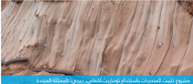
مشروع تثبيت المنحدرات باستخدام كونكريت كانفاس، ديربي، المملكة المتحدة
