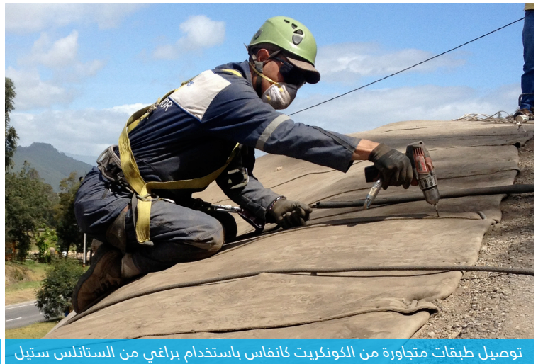
شكل توضيحي يوضح برغي تم إدخاله خلال مانع التسرب
