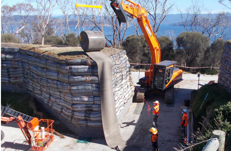
حماية جدران الأرض المثبتة ميكانيكياً لمنع التلف الناتج عن الحيوانات
