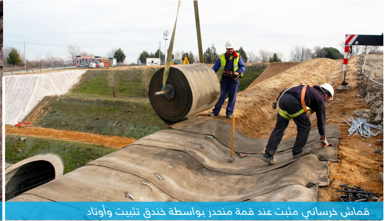
خندق تثبيت خرساني مردوم فوق الكونكريت كانفاس عند قمة منحدر
