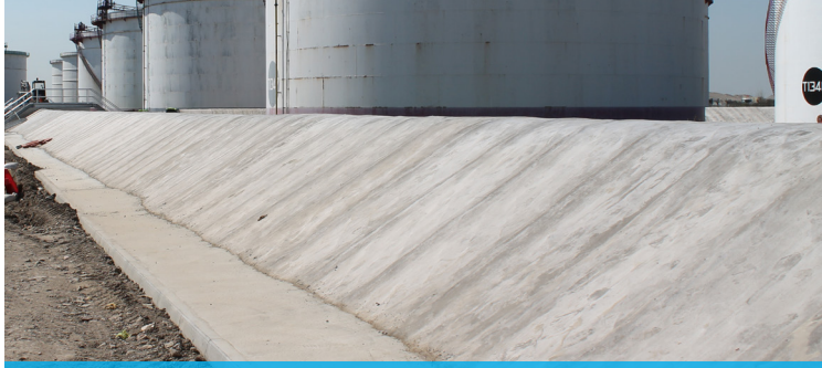
كونكريت كانفاس مثبت داخل خندق مصبوب بالخرسانة
